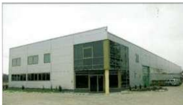
Новая контора - производственная база
